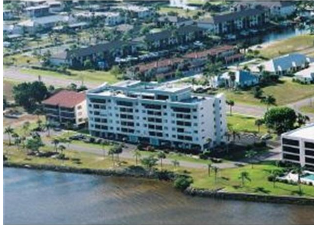
Palacio del Sol Condominium Punta Gorda, FL
